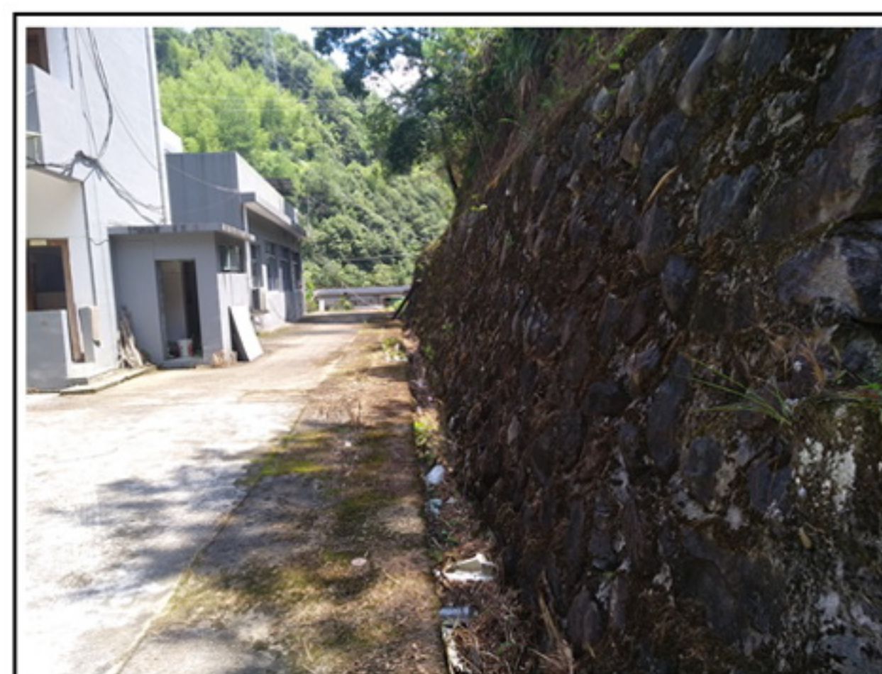
沿山侧开挖边坡防护挡墙及坡底排水沟。
