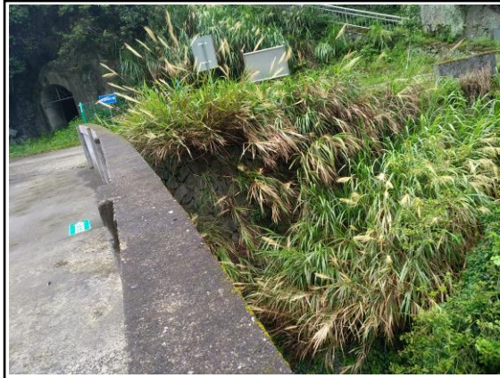
坝肩侧砌石护坡措施
