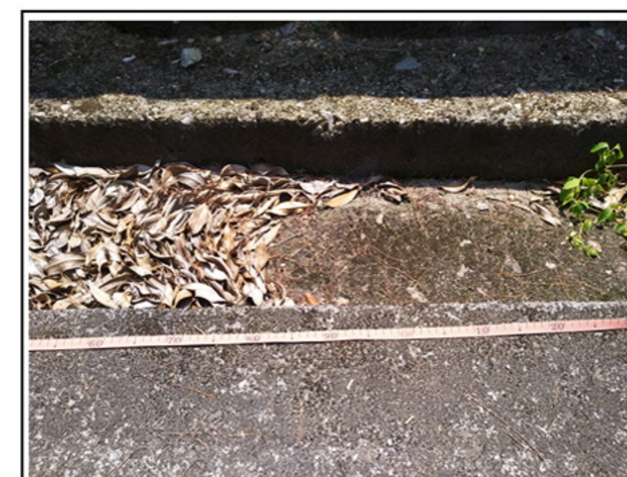
发电厂区排水沟调查。
