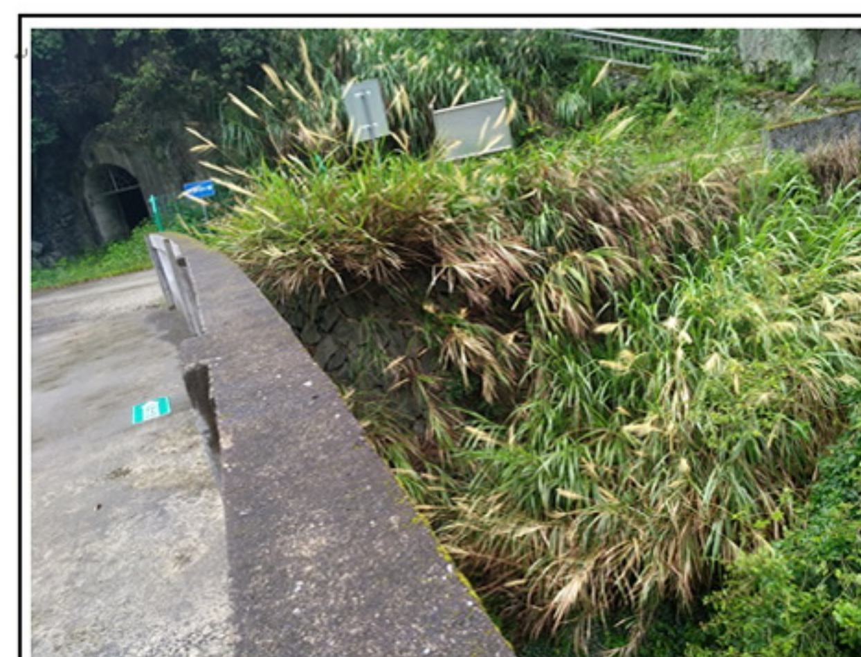
坝肩侧砌石护坡措施。
