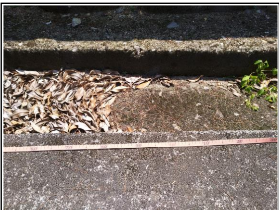
发电厂区排水沟调查
