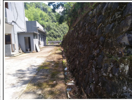
沿山侧开挖边坡防护挡墙及坡底排水沟。
