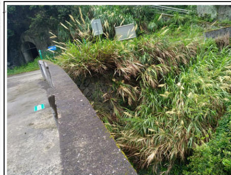
坝肩侧砌石护坡措施。
