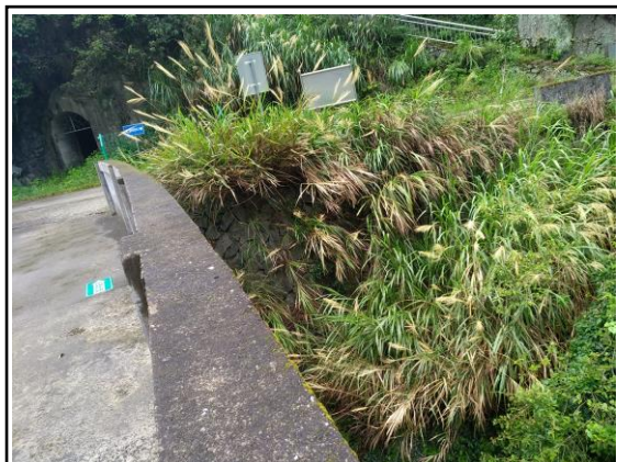
坝肩侧砌石护坡措施
