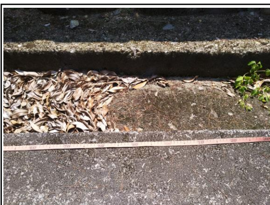
电站厂区排水沟调查
