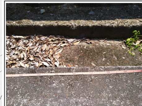
发电厂区排水沟调查。
